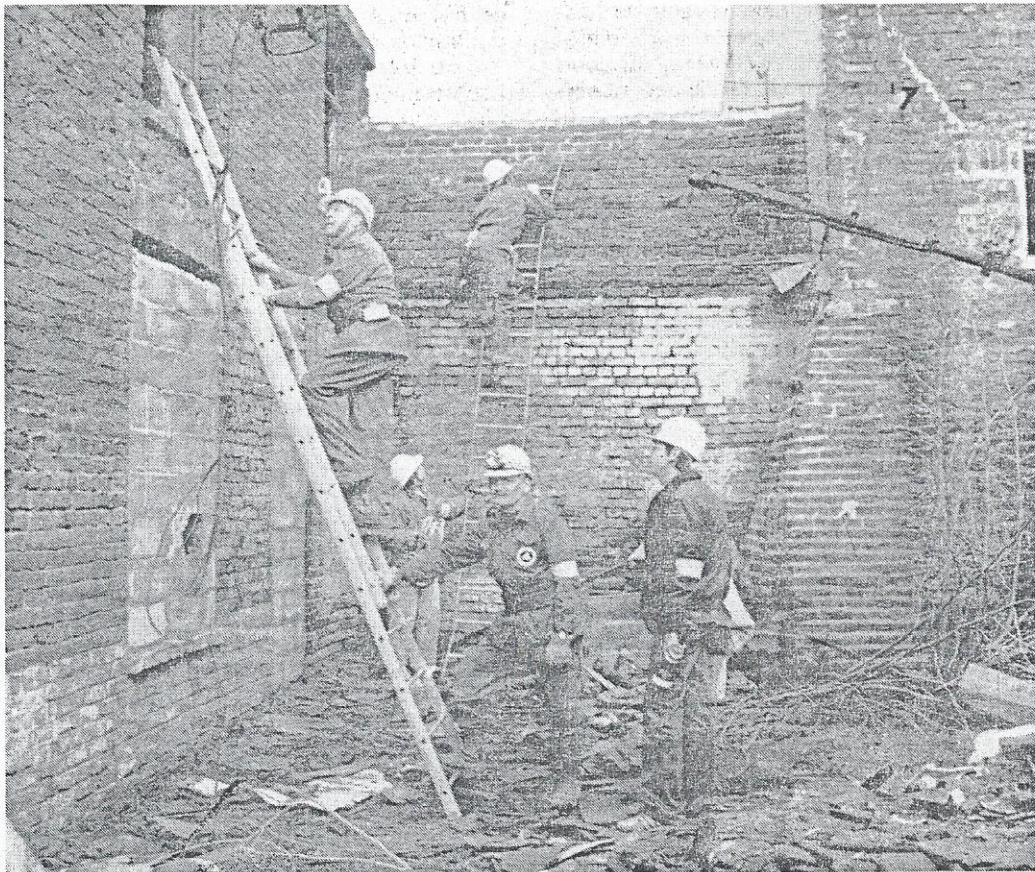
Les secouristes en reconnaissance dans les étages
